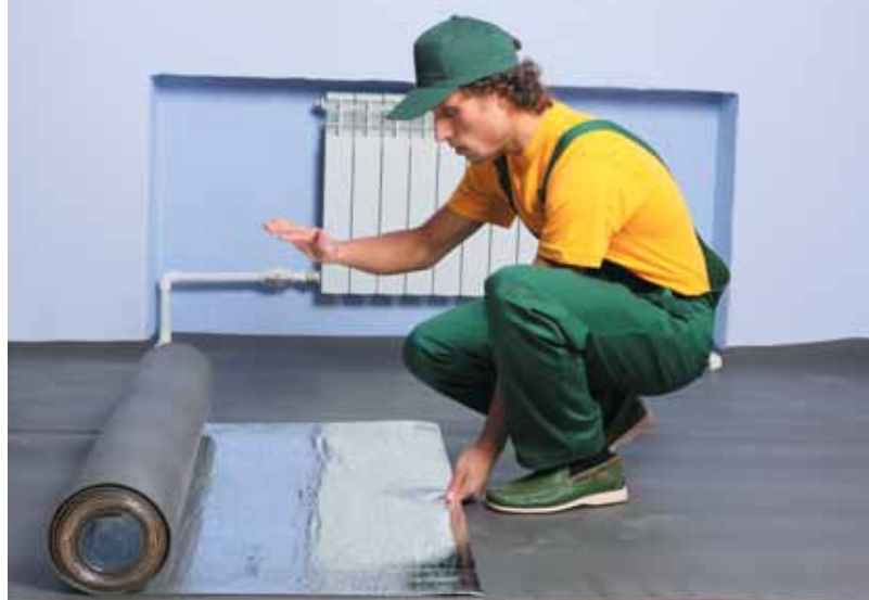
Рис. 2. Укладка теплоотражающего материала
