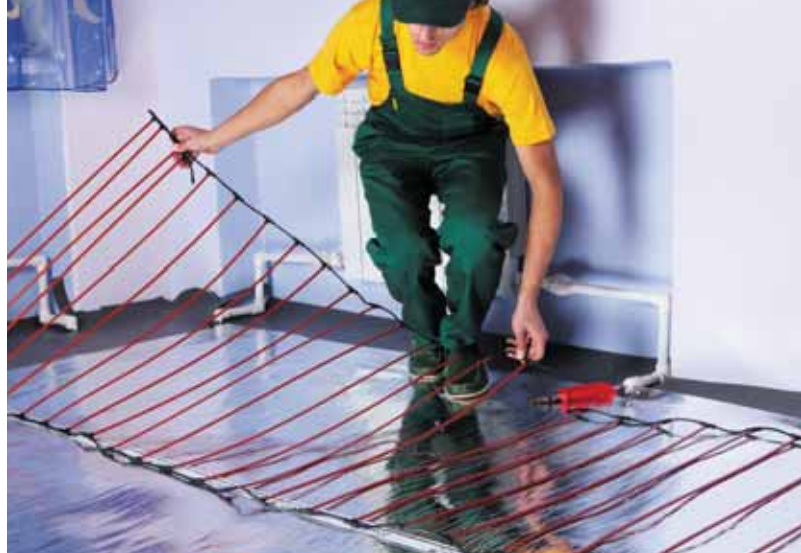
Рис. 5. Укладка разрезанной с одной стороны полосы UNIMAT на теплоотражающий материал с последующим разворотом мата
